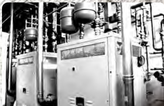
CENTRALE TERMICA E FRIGO
